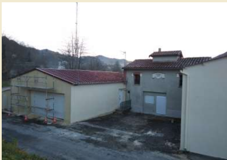
Rénovation de la caserne des pompiers
